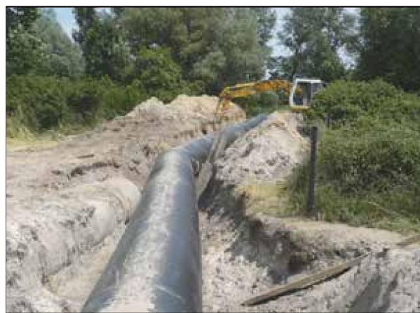
ul. Budowa OWD na ul. Partyzantów
