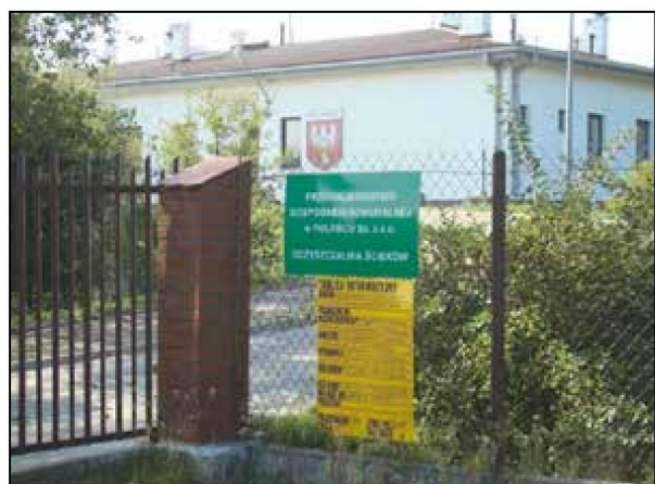
Budynki Oczyszczalni po wyremontowaniu zniszczonej elewacji
