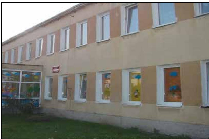
Przedszkole Publiczne w Połańcu (ul. Madalińskiego) – widok na ówczesny budynek szkolny
