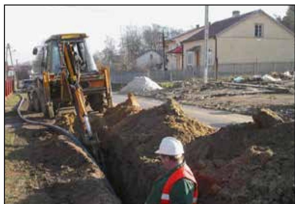
Ułożenie rurociągu kanalizacji w wykopie
