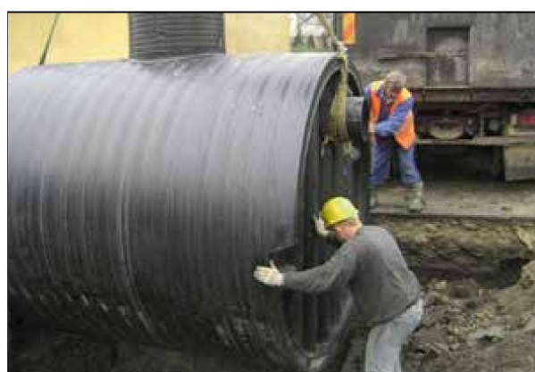
Budowa OWD – ul. Zrębińska
