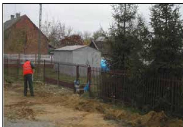
Zasypanie i zagęszczenie wykopu po wykonanej kanalizacji
